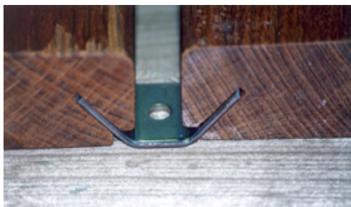
Detalhe de fixação
